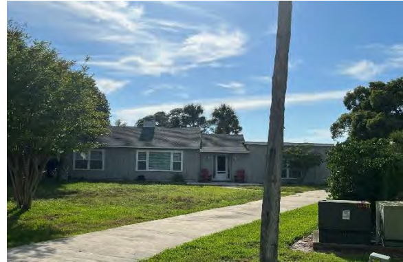
Photograph 15. SJ03759, 16 Ponte Vedra Circle.
