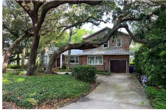
Photograph 19. SJ03766, 40 Ponte Vedra Circle.
