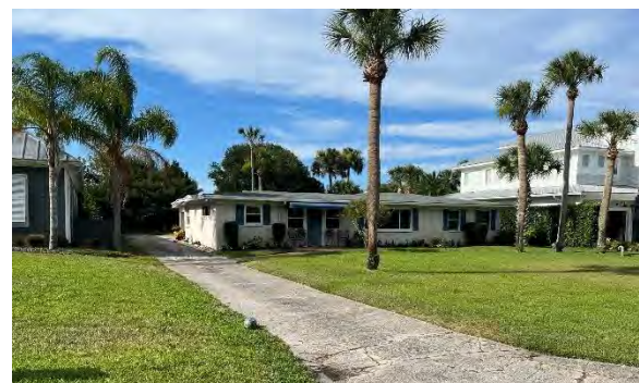
Photograph 272. SJ08212, 8 Ponte Vedra Circle.
