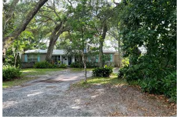
Photograph 17. SJ03763, 32 Ponte Vedra Circle.
